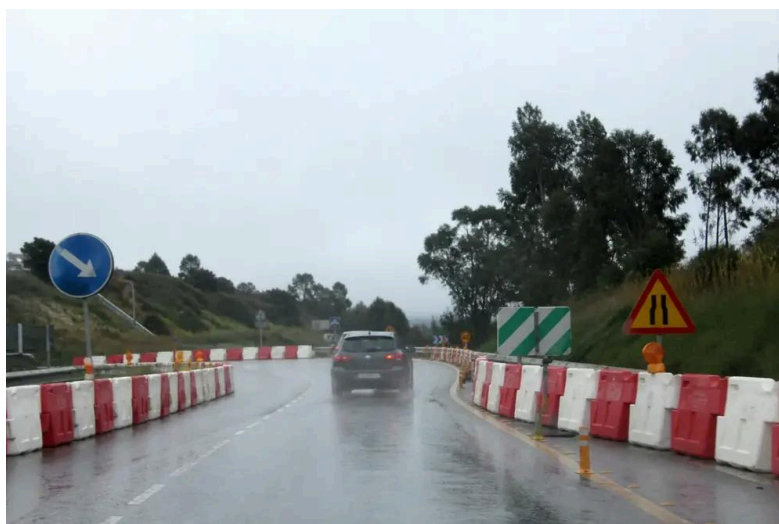
Obras con barreras rojas y blancas en una carretera mojada
