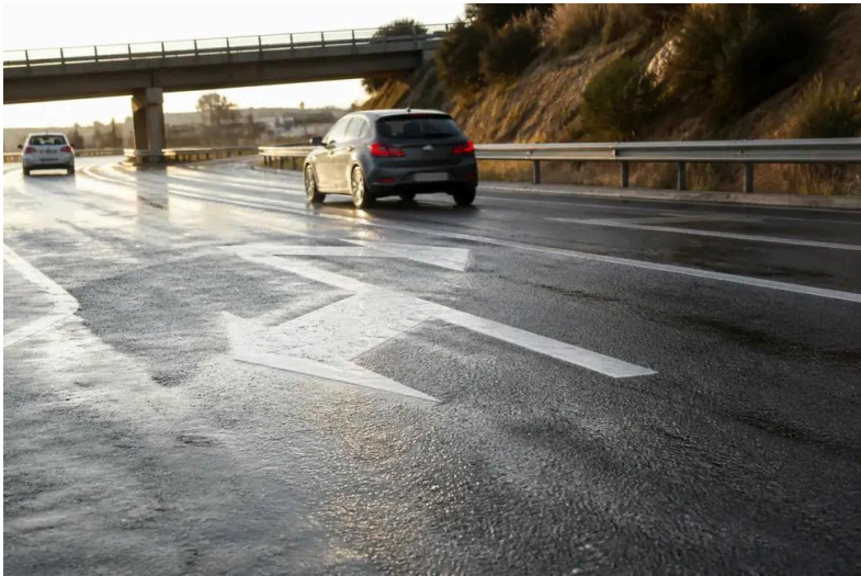
Flechas de selección de carril sobre calzada mojada bajo un viaducto
